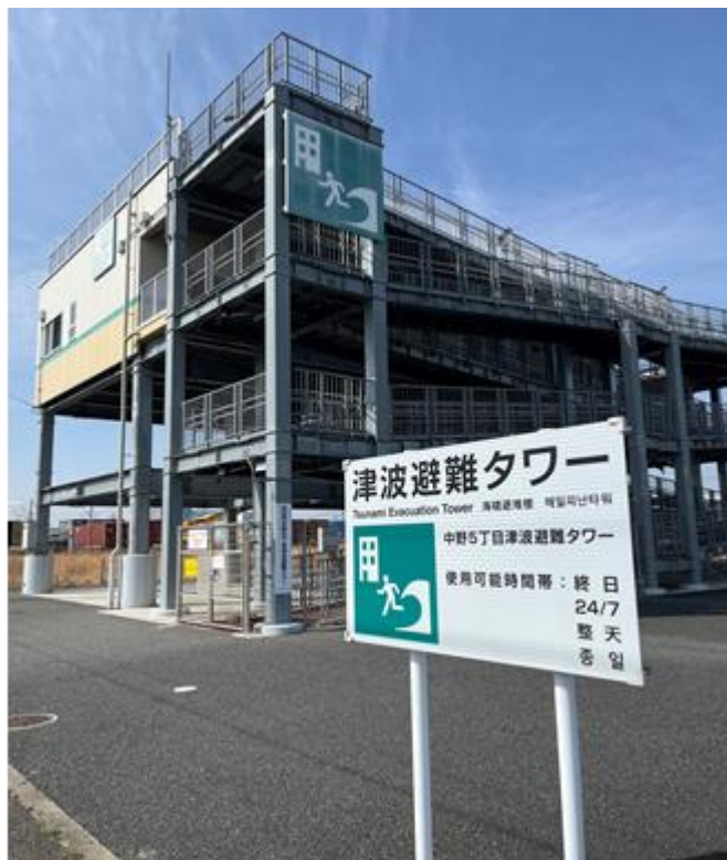
写真2 津波避難タワー (330人対応)
